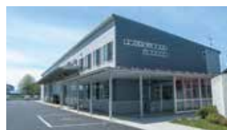
自動車実習棟 メカニックエンジニアリング科の自動車実習場として使っています。
