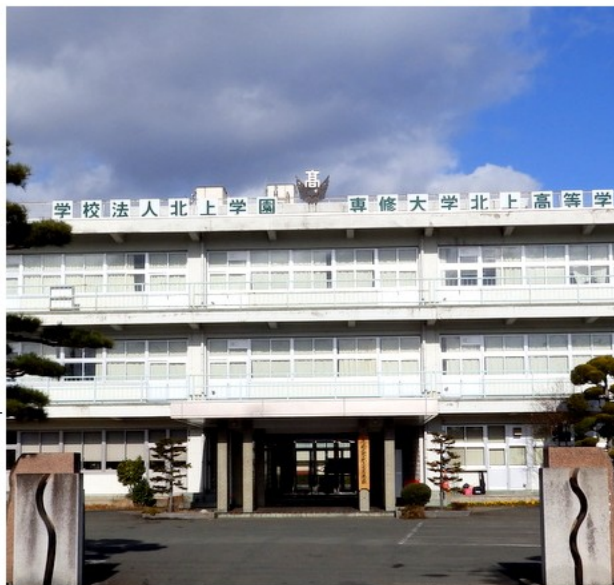
12月20日(木) 午後1時撮影 積雪0センチ
