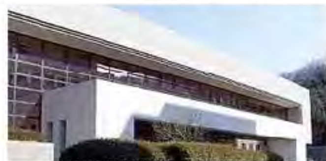
東京工科大学・日本工学院八王子専門学校体育館 (体操競技)
