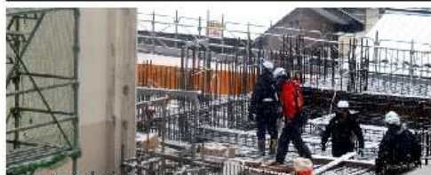
入学試験当日も新1号館建設作業が行われていました
